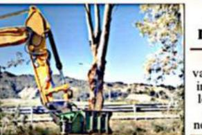
Il "Comparto C" dell'agglomerato industriale di Pisticci Scalo e sono stati determinati dalla necessità di intervenire sulla sottostante rete di fogna meteorica che è stata semidistrutta, in questi anni, dall'apparato radicale delle piante stesse a causa della notevole crescita degli alberi presenti in quel tratto.
